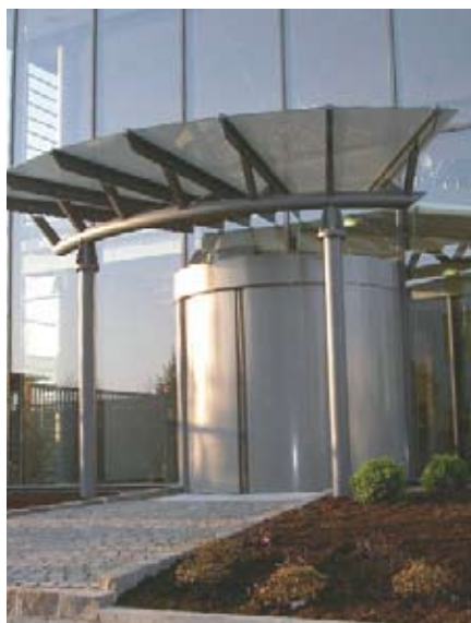
Seguridad adicional: puerta giratoria con hojas correderas, como cierre de protección nocturno
