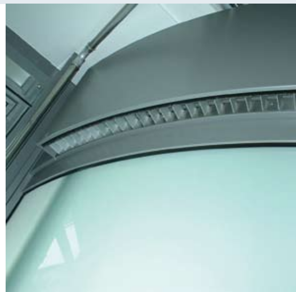
La instalación de cortinas de aire en puertas correderas circulares garantiza una agradable temperatura en las zonas de entrada
