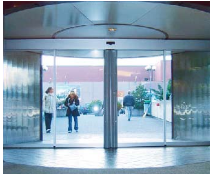
La puerta climática Kaba incorpora un sistema automático de barrera de aire que impide la entrada de aire frío o caliente además de aire contaminado del exterior.
