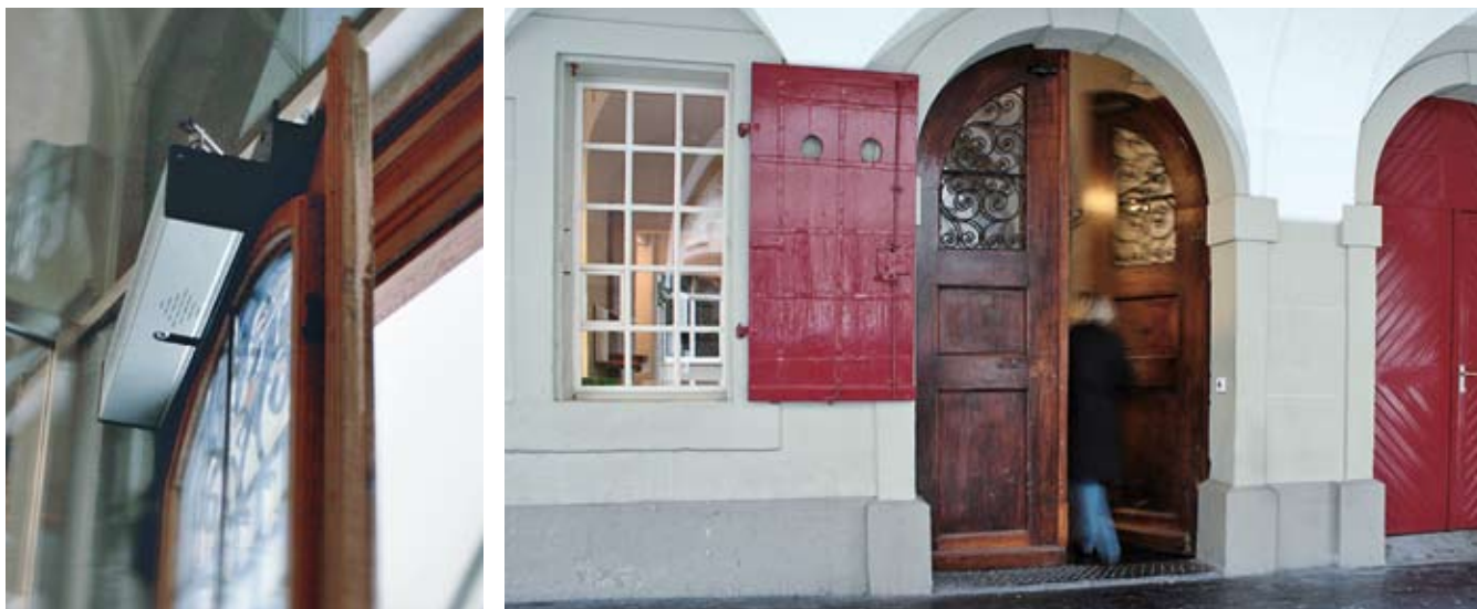
Las puertas pesadas se abren sin problemas gracias al mecanismo de accionamiento F4, permitiendo el acceso sin contacto.
